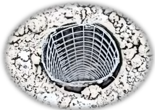
Рисунок 1. Установка арматурного каркаса в скважину.
